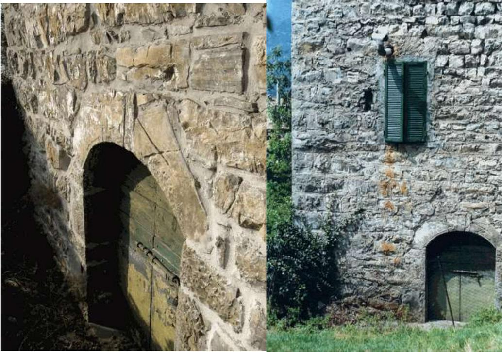
Fig 16: a destra la porta d'accesso al locale voltato seminterrato del nuovo corpo edilizio (6) a sud della torre e a sinistra (foto precedente ai restauri) la porta e sopra a sinistra della finestra la feritoia freccera.
