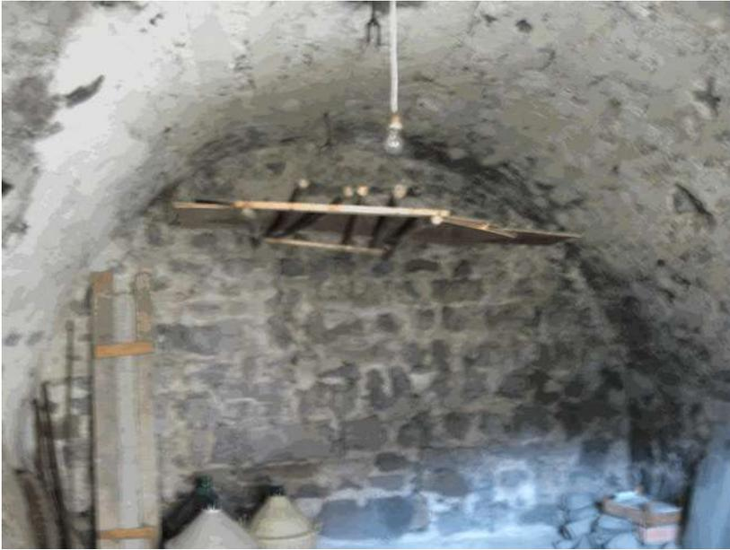
Fig 17: Il locale seminterrato del corpo (6) con la volta a botte medioevale.
