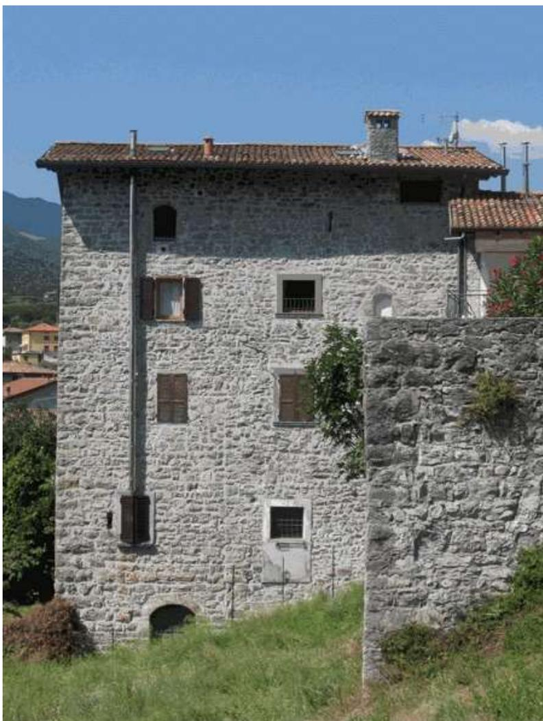
Fig 24: Il fronte est attuale del corpo costituito dall'unione della torre (5) a destra e del corpo (6) ad essa addossato a sud a sinistra, con il nuovo tetto a due falde. In primo piano a destra lo spigolo a sud est del nuovo recinto orientale.
