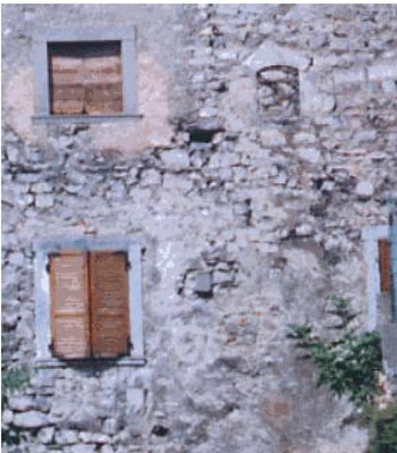
Fig 13: foto (scattata prima dei recenti restauri) particolare del fronte est della casa-torre (5) con in evidenza la feritoia freccera e la finestra al secondo piano (qui ancora tamponata)
