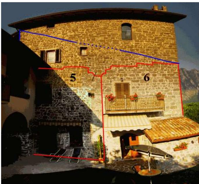
Fig 20: il lato occidentale dei corpi di fabbrica (5-6) con in evidenza i resti dopo le demolizioni (in rosso) e il sopralzo (in blu) per realizzare il nuovo tetto a una falda inclinato da nord a sud.
